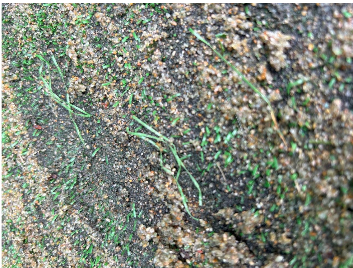
写真3：県総現在のオムニコート雨の日の状態、雨が降るとPPは軽いので浮いてきます。
